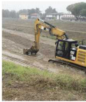
Maschinari al lavoro nell'area di tracimazione di via Cimatti
